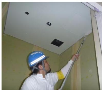
←天井への施工状況
